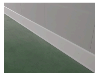
Zócalo instalado en esquina interior y en tramo recto sobre panel.
