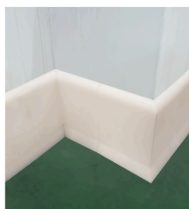
Zócalo instalado en esquina interior y en tramo recto sobre panel.
